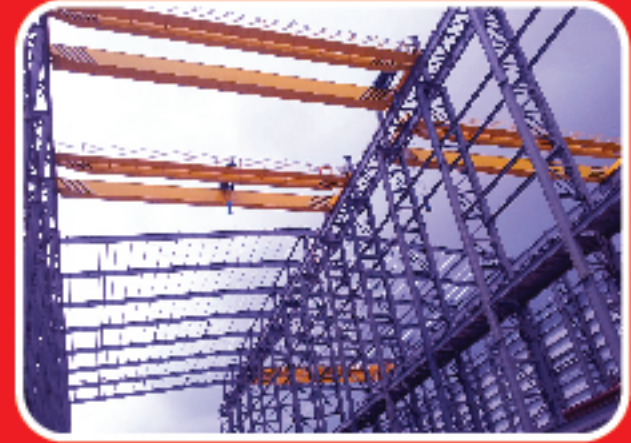
Kết cấu nhà xưởng
