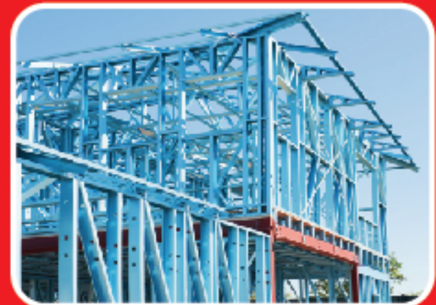
Kết cấu nhà xưởng
